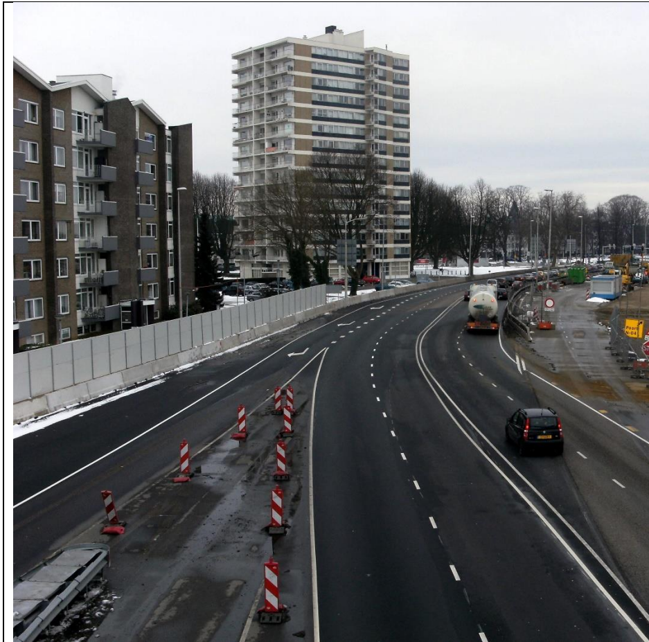
Koning Willem Alexander Tunnel Maastricht 2300 m 2015, Maastricht, Netherlands
